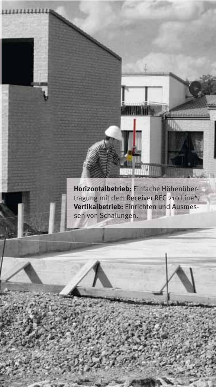
**Horizontalbetrieb:** Einfache Höhenübertragung mit dem Receiver REC 210 Line\*.
